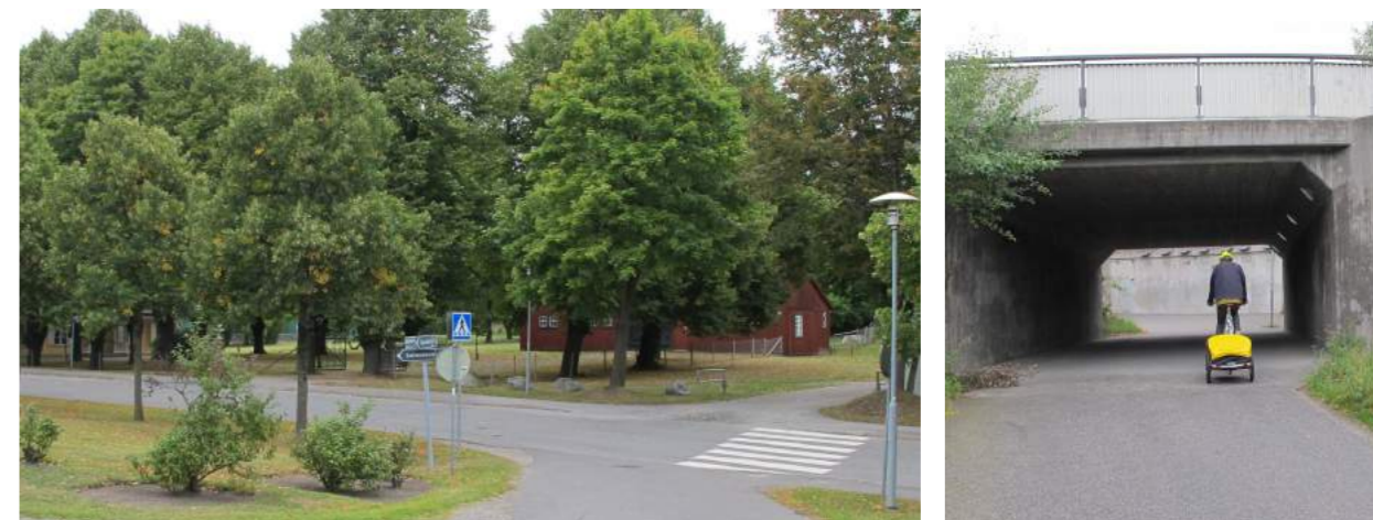
Figur 39. Skarp sväng efter gc-tunneln in på Lings väg. Figur 40. På bägge sidor om gc-tunneln vid Annelund finns skarpa svängar. Foto: WSP
