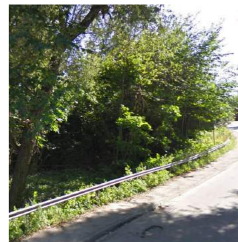
Figur 44. Igelbäcken rinner under bron som breddas för att rymma snabbcykelvägen. I samband med breddningen byts trumman ut. Foto: Google maps
