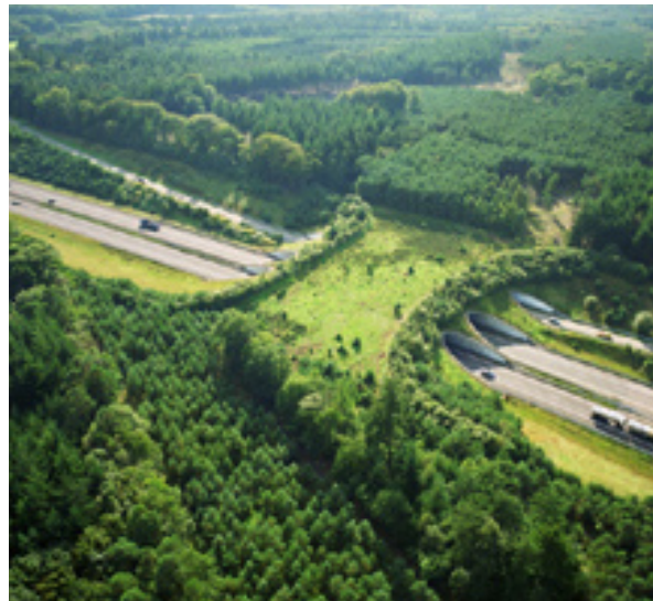
Möjlig utformning av ekodukt, fotografi från Nederländerna. En ekodukt diskuteras som länk mellan Järvafältet och nationalstadsparken i Nollalternativet liksom vid utbyggnad av Mälarbanan via Kista korridor.
