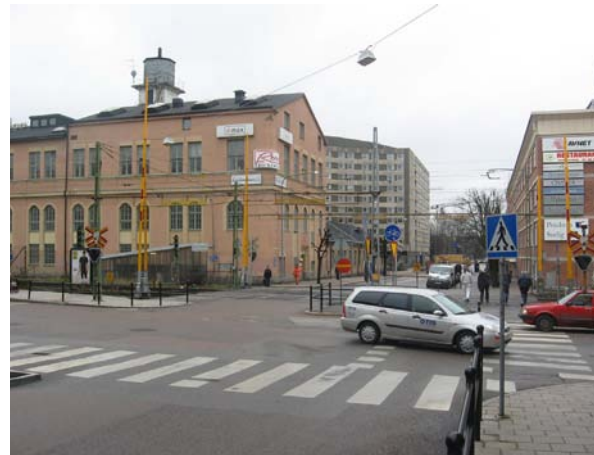
Plankorsning på Esplanaden i centrala Sundbyberg. Foto: ÅF.
