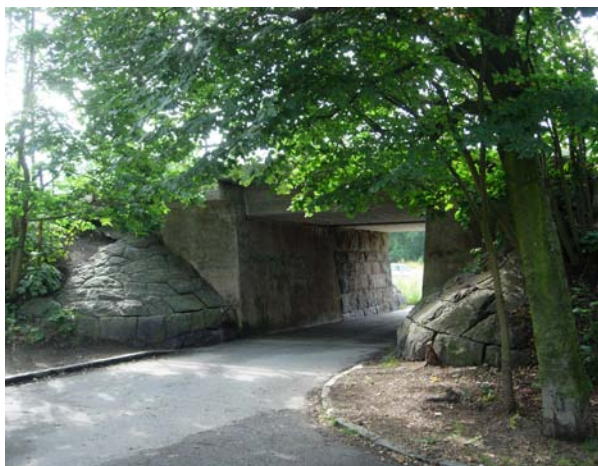
Ankdammspassagen ger idag ett välkomnande intryck med de vackra brokonerna och den lummiga grönskan. Genomsikten till andra sidan är också mycket viktig för att tunneln inte ska kännas otrygg.
