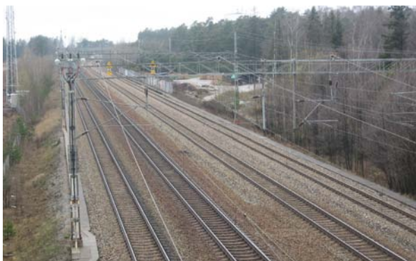
Fyrspårsjärnväg på Ostkustbanan vid Silverdal. Foto: ÅF.
