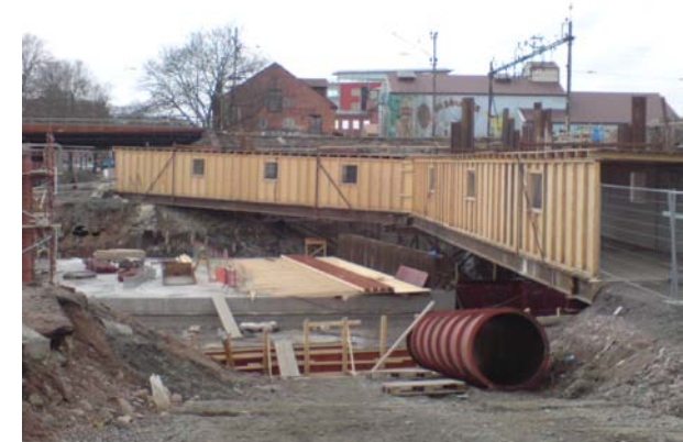
Exempel från Uppsala på tillfällig lösning för gång och cykeltrafik under byggtiden.
