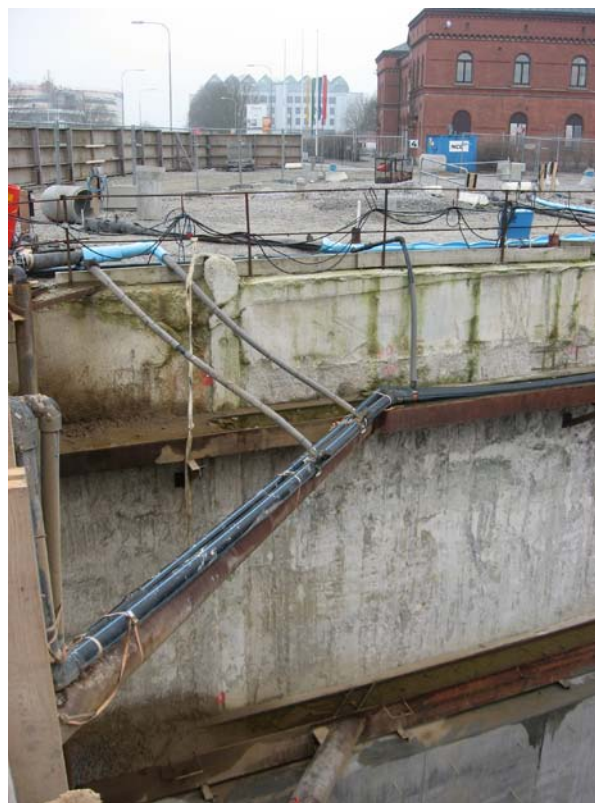
För att hålla uppe schakten krävs slitsmur eller spont. Bilden visar slitsmur från Citytunneln.
