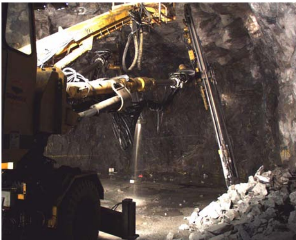
Bergborrningen är till stor del automatiserad.
