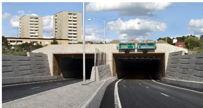
Exempel på tunnelpåslag. Nerfart till Södra länken. Vägen ligger i tråg fram till tunnelpåslaget som markeras med en tydlig portal. Trågets väggar är sparsamt men dekorativt gestaltade och ger ett väl genomarbetat intryck.
