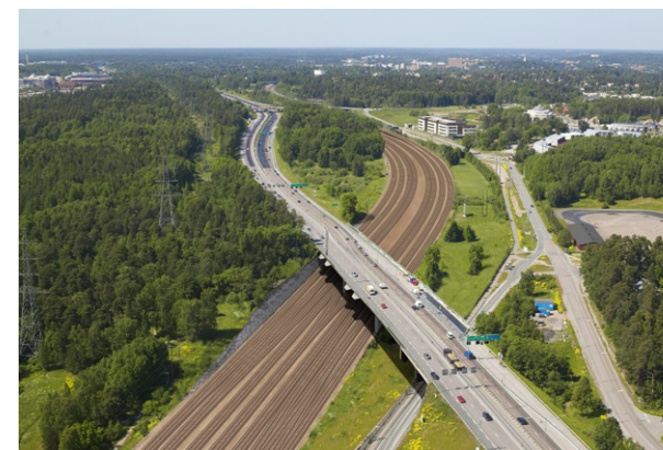
Där E4 och järnvägen möts bildas en bred infrastrukturkorridor.
