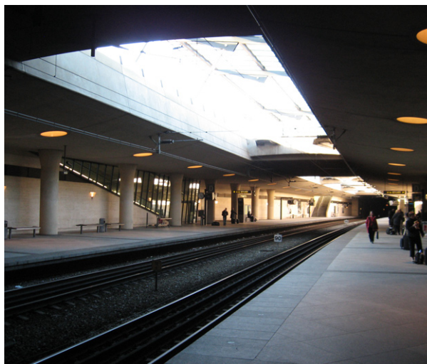
Med ljusschakt kan även underjordiska plattformar få dagsljus. Foto från Kastrups station i Danmark.
