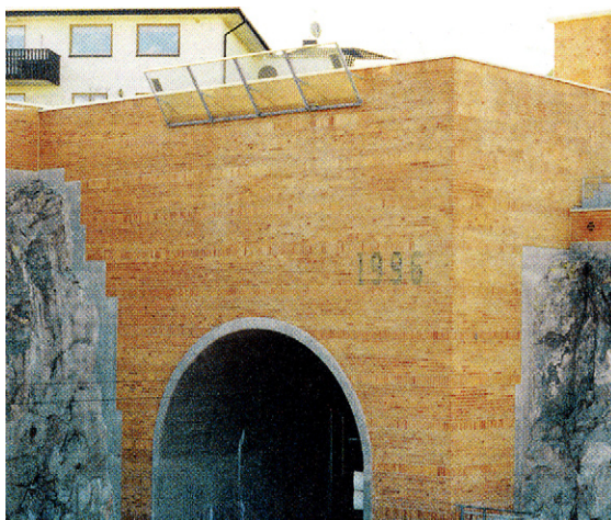
Ett välgestaltat tunnelpåslag blir ett tillskott i stadsmiljön
