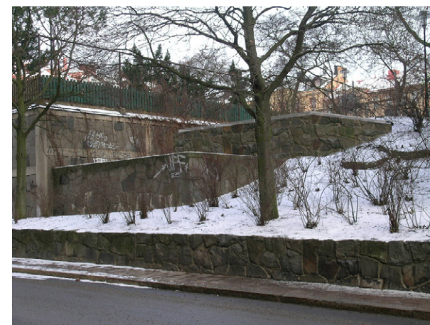
Referensexempel brandgasventilationshus. Banverket, Citybanan. Arkitekt: Ahlqvist & Almqvist arkitekter
