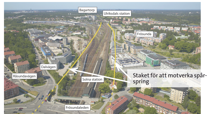
Solna station med bangården norr om stationen. Det stora landskapsrummet sträcker sig från Brunnsviken till Råstasjön. Bangården gör rummet otillgängligt och landskapets läsbarhet försvinner i och med ny bebyggelse i dalbotten.
