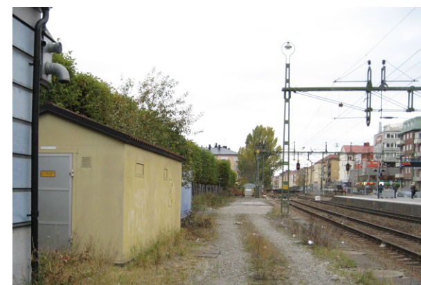
Sidostråk med skräpiga ytor kommer att försvinna när spåren går i tunnel.
