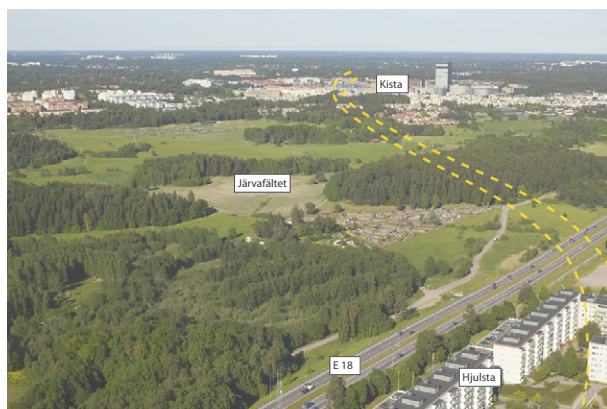
Korridor under mark. Från Hjulsta mot Kista. Kista Science Tower skymtas långt bort i bilden.
