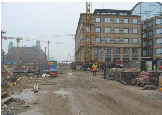
I Sundbyberg kommer byggandet att ske i stadsmiljö (Bild från Citytunneln i Malmö).
