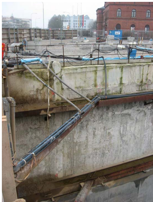
För att hålla upp schakten krävs slitsmur eller spont. Bilden visar slitsmur från Citytunneln.
