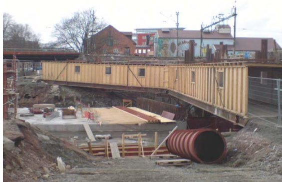
Exempel på tillfällig lösning för gång och cykeltrafik under byggtiden i Uppsala.
