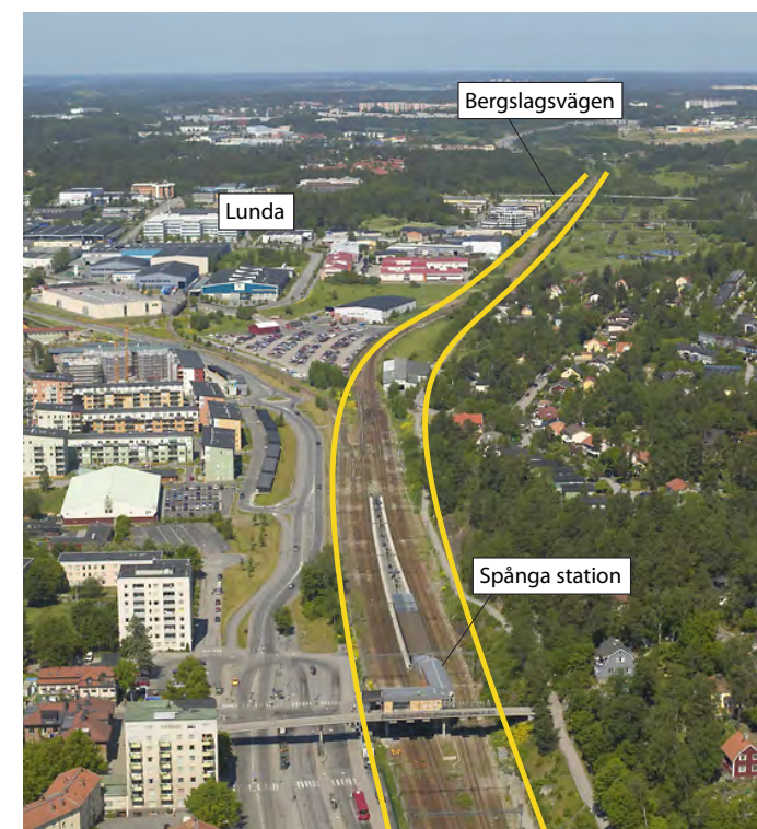
Sträckan strax norr om Spånga pendeltågsstation till strax söder om Barkarby pendeltågsstation.
