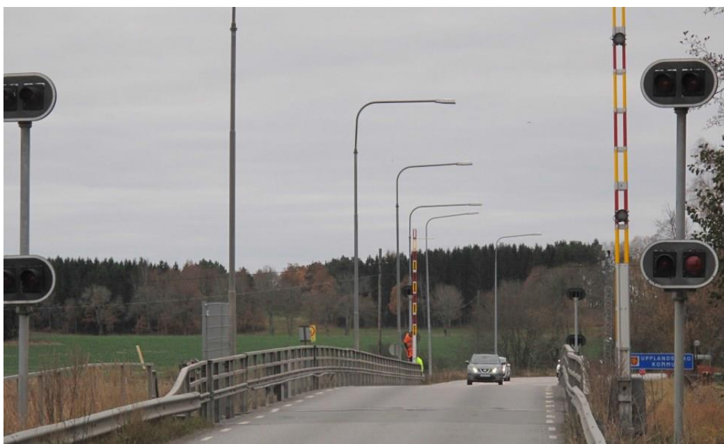
Figur 3. Foton bron sedd från öster (överst), väster samt från norr (samtliga bilder BATMAN, Trafikverket).
