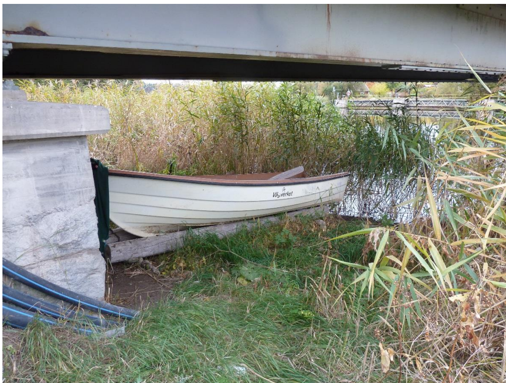
Figur 9. Strandpassage vid det södra landfästet.
