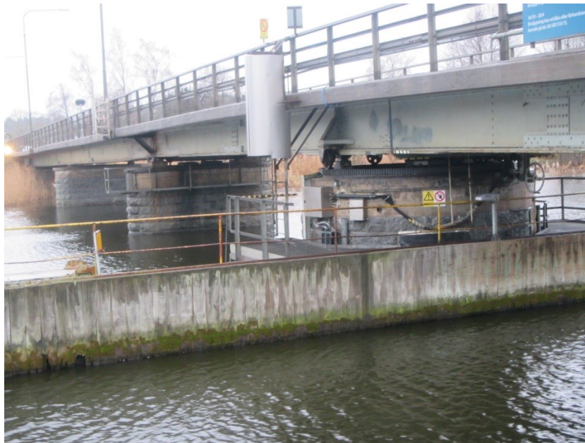
Figur 5. Bilden visar enpelarstödet för svängspannet (foto: Norconsult).
