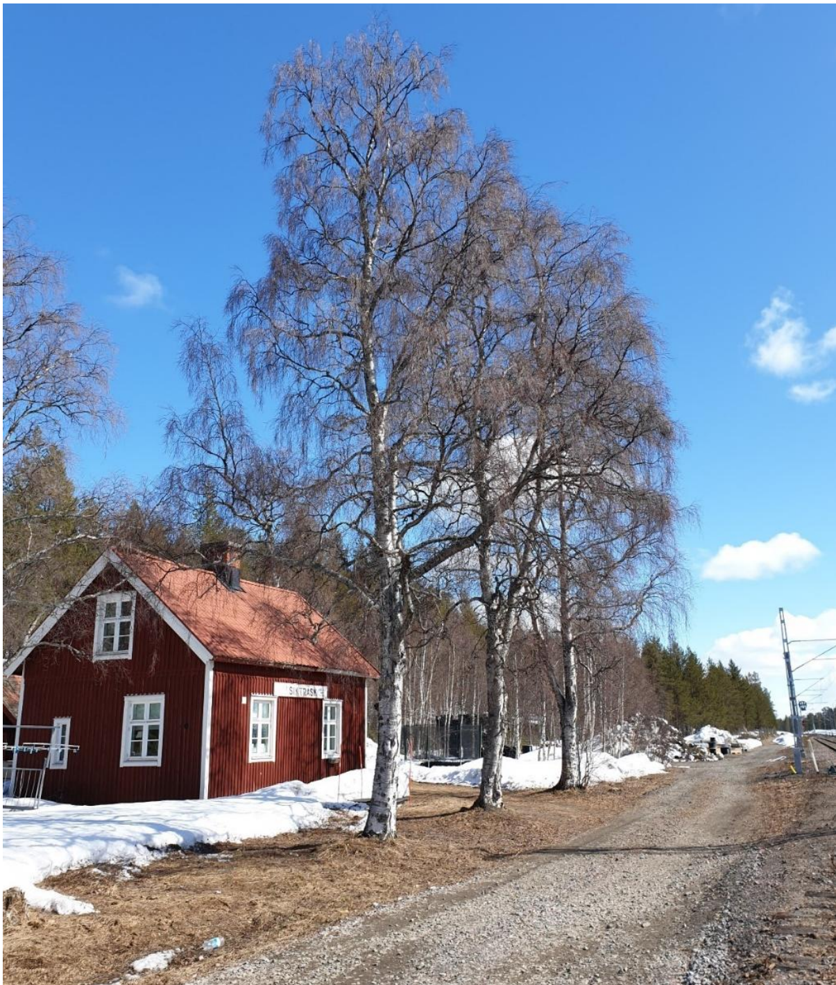
Figur 5.9–1. Banvaktarstugan vid Sikträsk driftplats avgränsas visuellt från spårområdet av en trädrad med björkar. På banvaktarstugan sitter en skylt från järnvägsstationen som revs på 1980-talet.
