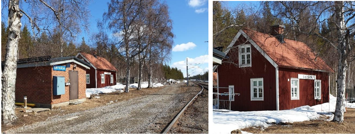
Figur 5.8-1. Foton på banvaktarstuga, till vänster med intilliggande trädråd och teknikbyggnad i tegel.
