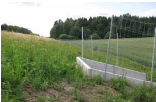
Exempel på viltuthopp där marknivån utanför stängslet är lägre än innanför. Djur kan ta sig ut, men inte in på vägområdet. Bilderna kommer från E4 mellan Mantorp och Linköping.
