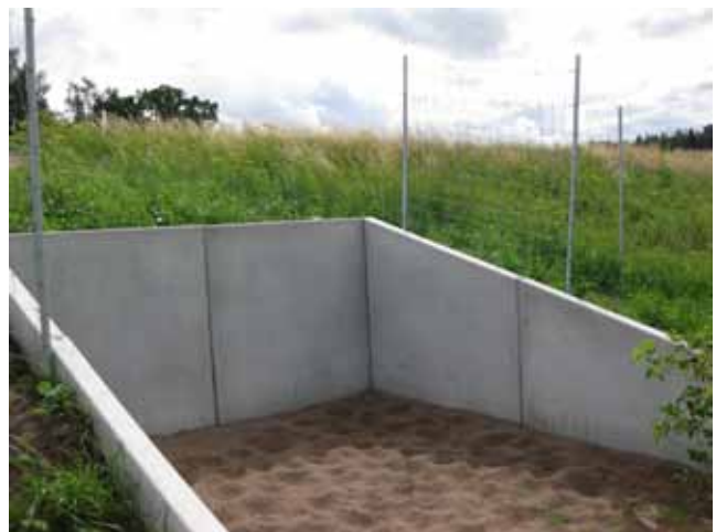
Exempel på viltuthopp där marknivån utanför stängslet är lägre än innanför. Djur kan ta sig ut, men inte in på vägområdet. Bilderna kommer från E4 mellan Mantorp och Linköping.
