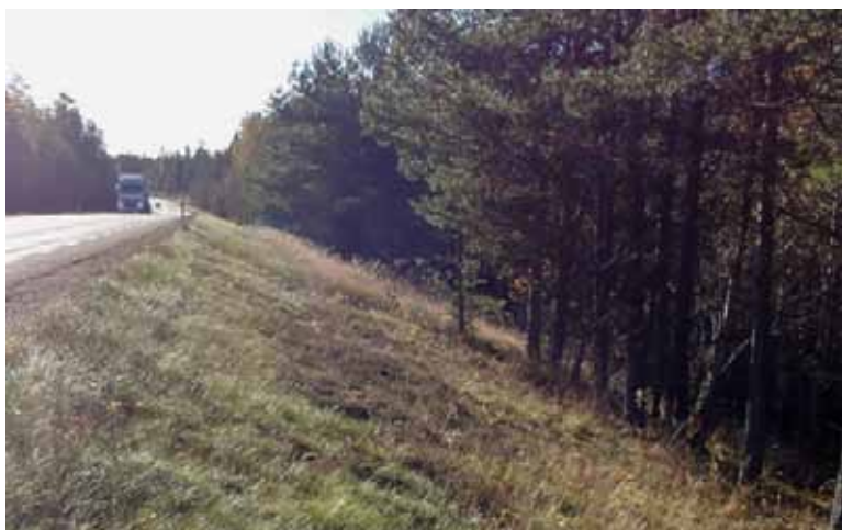
Längs vägen finns partier med branta slänter.
