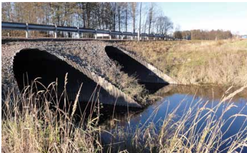
Vitlandaån korsar vägen i två rörbroar.
