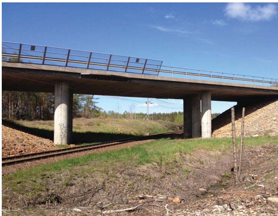
Figur 4. Överfart över järnväg på bro.
