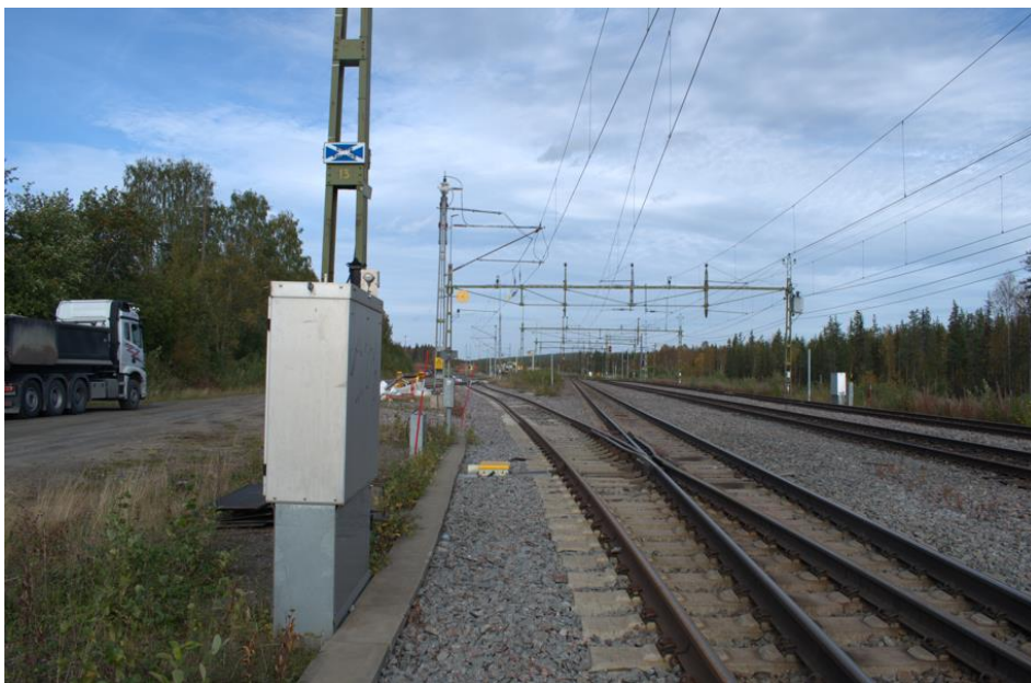
Figur 46 Stickspåren som leder till lastområdet norr om stationshuset, foto taget i samband med platsbesök i september 2024. Till skillnad från 2018 är delar av stickspårens träslipers numera utbytta mot betongslipers och spårspärren är borta.
