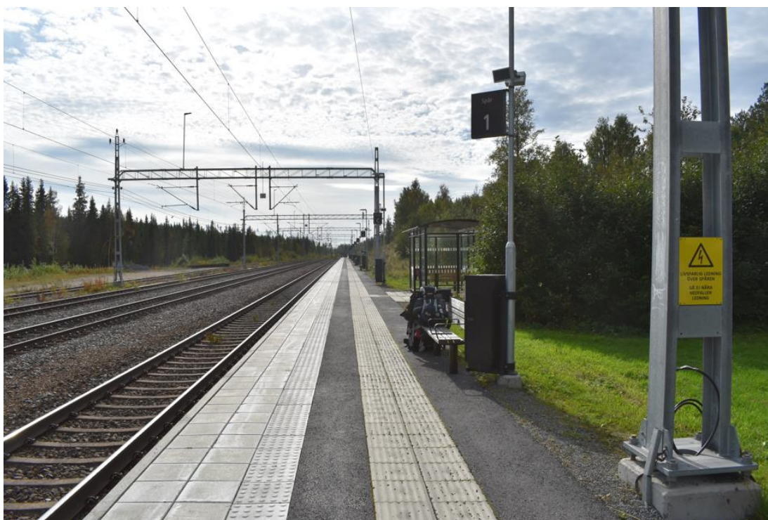
Figur 27 Vy över plattformen och spårområdet söder om stationshuset. Till höger i bild står en av de moderna ledningsstolparna.
