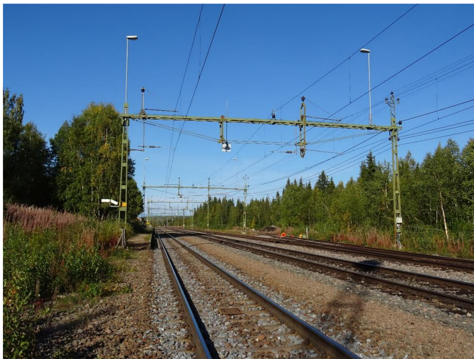
Figur 43 Spårområdet, vy mot norr tagen i samband med dokumentationen 2018. Spår 1 som löper närmast stationshuset vilar på betongslipers.
