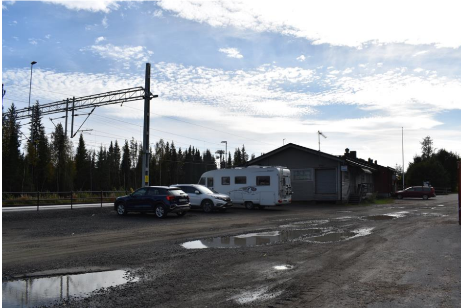
Figur 36 Stationshuset med godsmagasin sett från den norra infarten i samband med platsbesöket i september 2024. Här blir höjdskillnaden från låg till mellanhög plattform tydlig. Plattformen skärmas tydligt av från den grusade parkeringsytan med ett nytt räcke och en ny ledningsstolpe har tillkommit.
