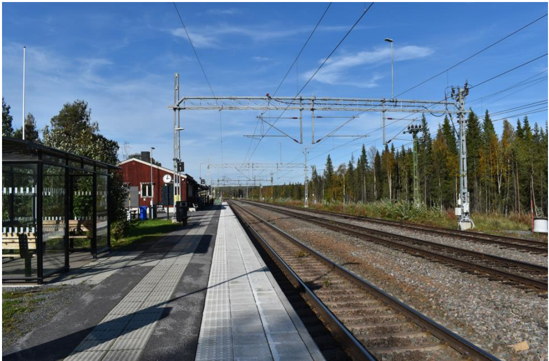
Figur 25 Vy från söder över plattformen och spårområdet med spår 1 närmast plattformen.
