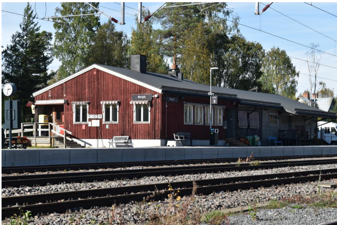
Figur 34 Funktionsområde Station, stationshuset sett från andra sidan spårområdet i samband med platsbesöket i september 2024. Här syns de mellanhöga betongelementen som tillkom i samband med plattformshöjningen. Den gröna äldre ledningsstolpen har bytts ut mot en modern ledningsstolpe som placerats längre söderut på plattformen.
