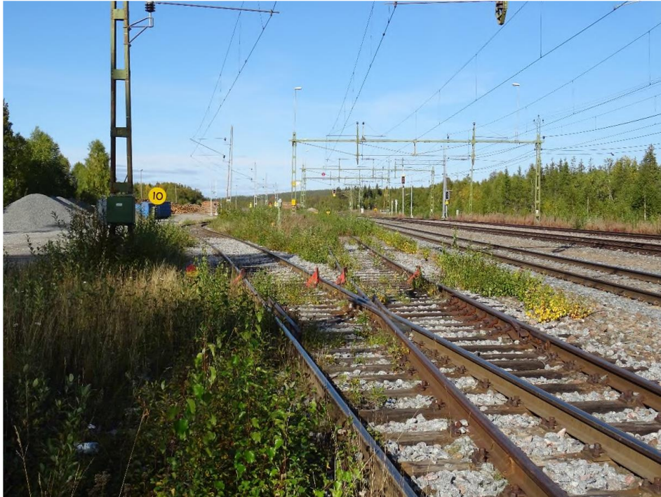
Figur 45 Stickspåren som leder till lastområdet norr om stationshuset med låga räler på träslipers och spårspärrar. Vy mot norr tagen i samband med dokumentationen 2018.
