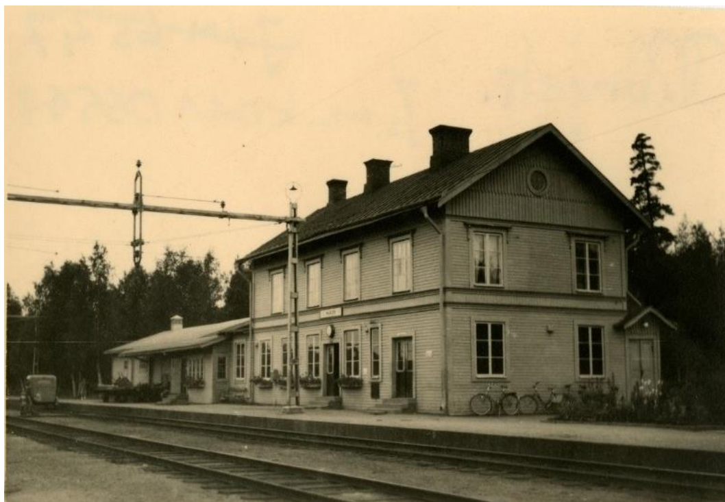
Figur 7 Murjeks stationsbyggnad under 1940-talet. Här syns det tillbyggda godsmagasinet söder om stationsbyggnaden. Källa: Digitalt museum.
