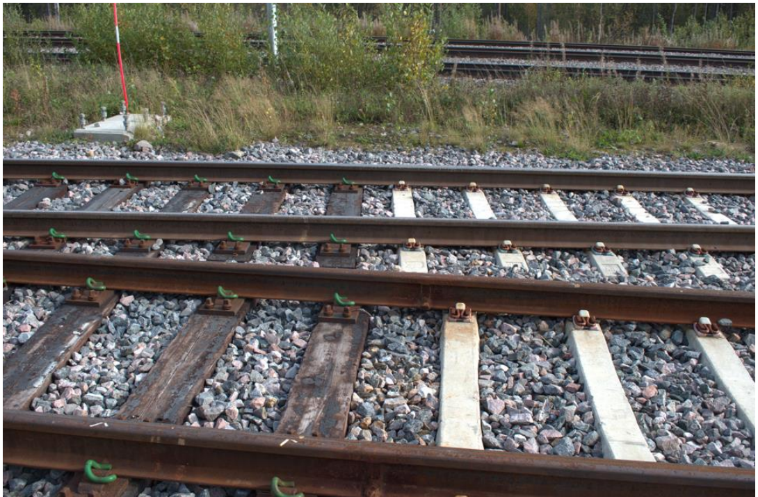
Figur 29 Närbild på stickspåret och övergången mellan trä- och betongslipers.
