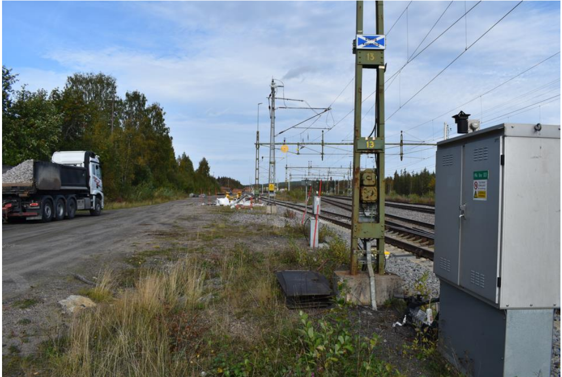
Figur 28 Vy över spårområdet norr om stationshuset. Till höger i bild går det att se hur stickspåret viker av till en lastplats.
