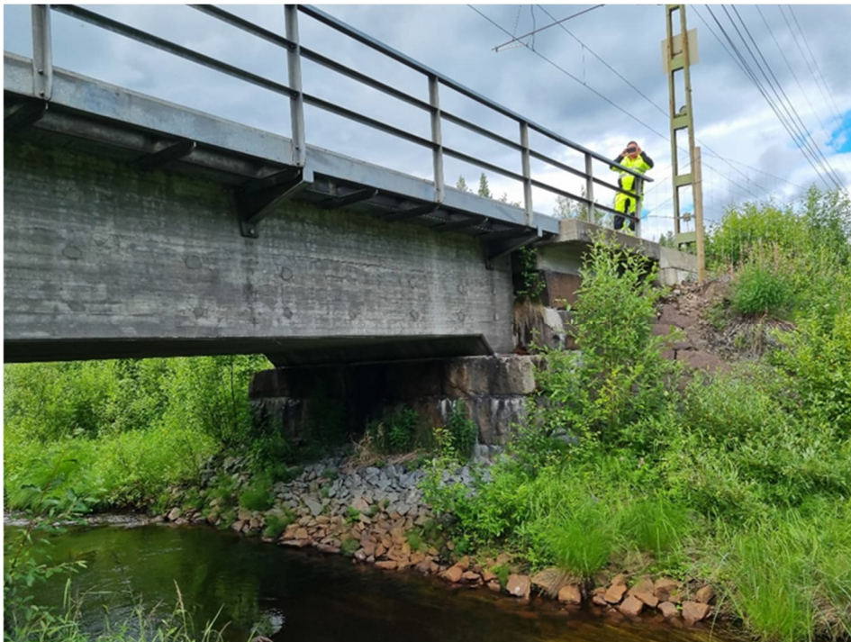
Figur 20. Befintlig bro över Finnstabäcken.
