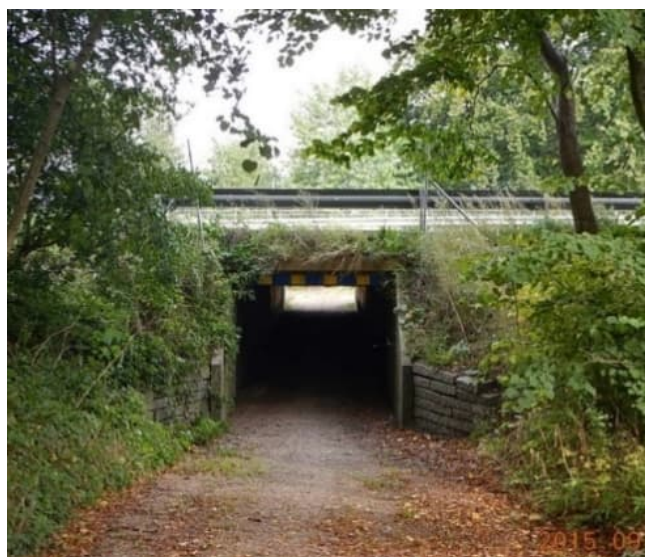
Figur 19. Befintlig vägbro, 12-1196-1, över gångväg.
