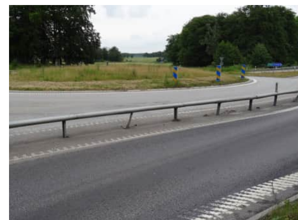
Figur 33. Bild över befintlig E65 samt rondell vid Sturupsvägen
