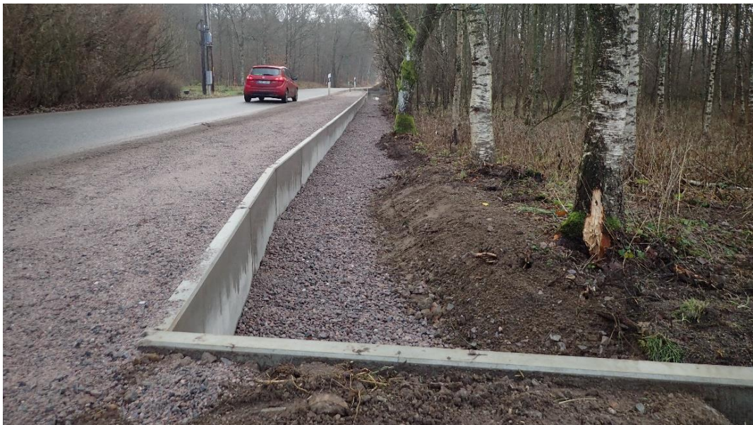
Figur 73. Bilden visar hur en groddjursbarriär kan se ut. Foto: Per Nyström, Ekoll AB.
