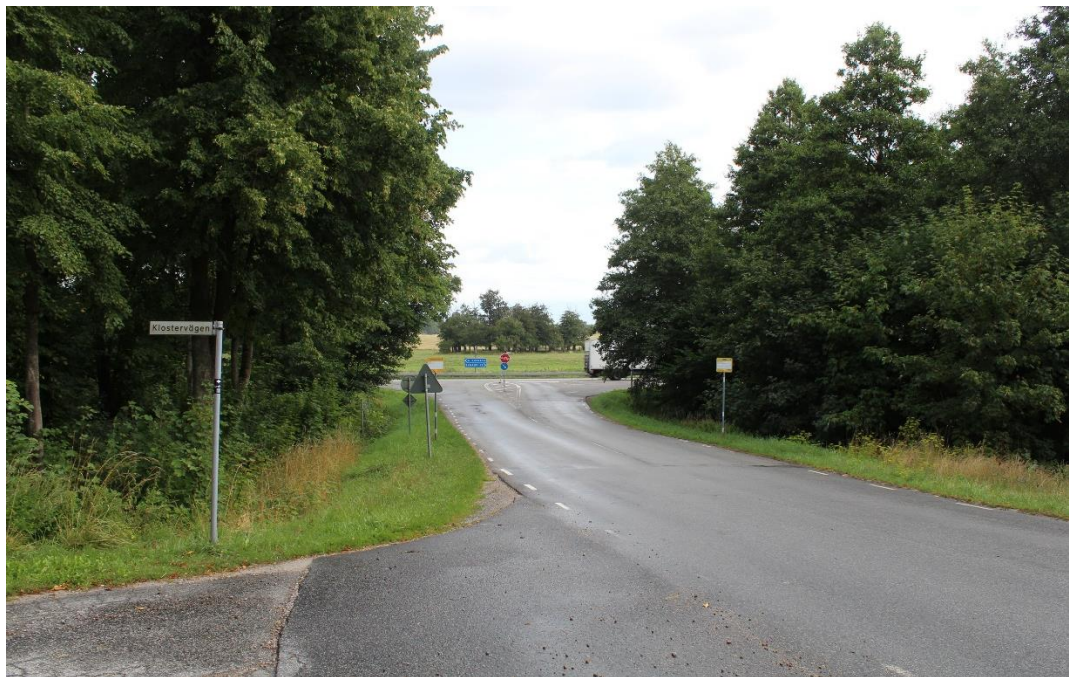
Figur 44. Utblick mot ny E65 och Håkanstorpsbron från korsningen Börringe stationsväg och Klostervägen.
