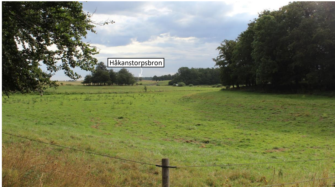
Figur 43. Utblick mot ny E65 och Håkanstorpsbron från korsningen väg 813 och befintlig E65.
