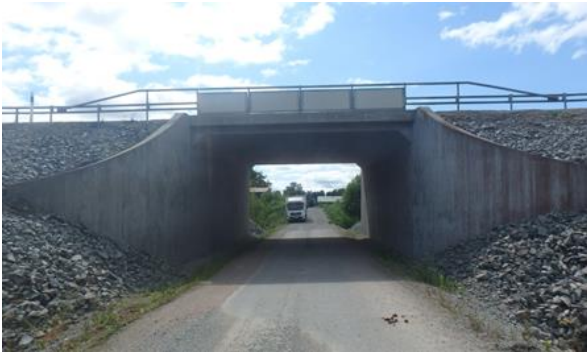
Figur 4.7.3:2 Bro över enskild väg för väg 56/70.
