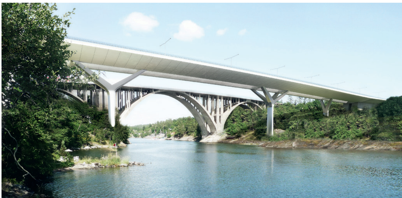
Vi bygger den nya Skurubron söder om den befintliga bron.
