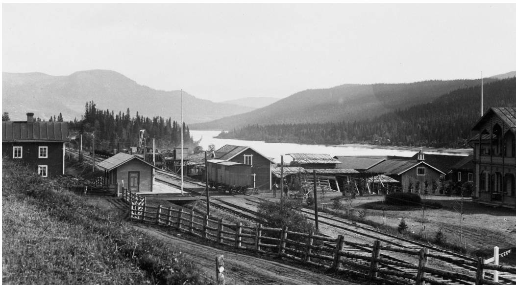
Figur 19. Tegefors sågverk låg intill järnvägen och drevs av vattnet från Indalsälven. Verket låg i direkt anslutning till den tjänstebostad och disponentvilla med uthus som finns kvar idag. Längst till vänster på bilden syns tjänstebostaden intill det tidigare hållplatsläget.
