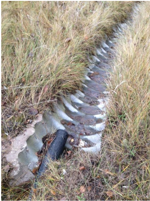
Figur 22 Exempel halvpipa som kan anläggas för att undvika erosion vid branta slänter.
