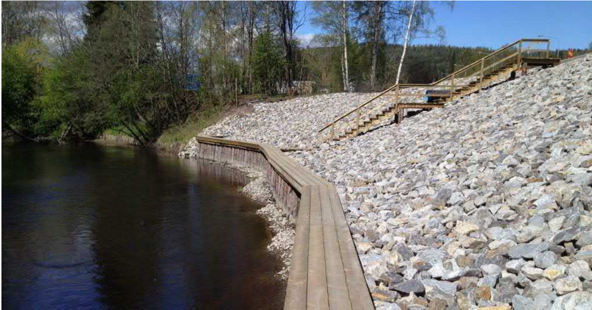
Figur 15. Exempel på hårt erosionsskydd kombinerat med brygga för friluftsliv och fiske. Trafikverket Sundsvall.
