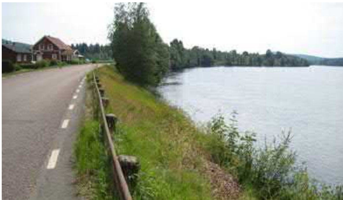
Figur 47. Befintlig väg 62 vid Ämtbjörk
