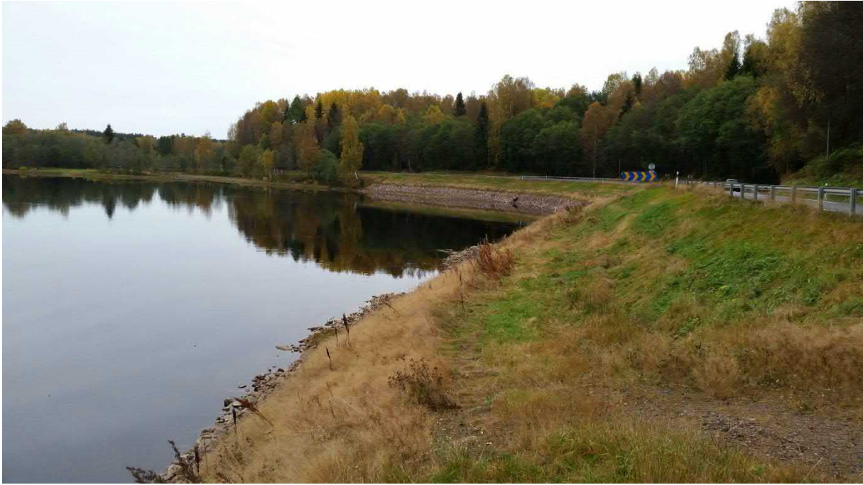
Figur 12. Befintligt kombinerat erosionsskydd längs Klarälven söder om Edebäck. Erosionsskyddet sträcker sig ända upp till krönet på slänten. Från högvattennivån och uppåt har skyddet av sten täckts av jord och vegetation från området. Detta har gjorts för att få erosionsskyddet att smälta in i omgivningen.
