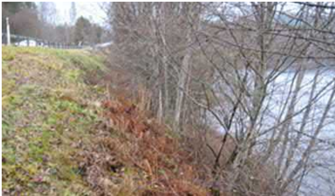
Figur 41. Befintlig vägslänt söder bron vid Fastnäs
