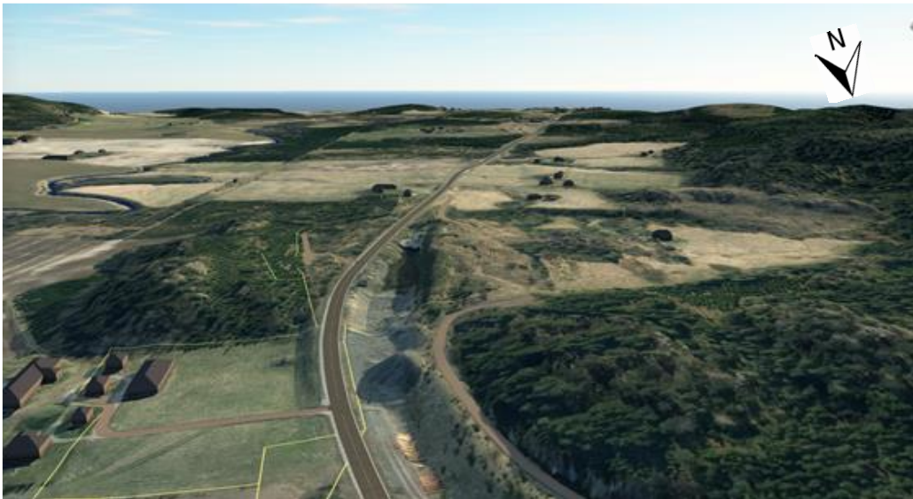
Figur 5-3. En terrängmodell över den befintliga vägen sedd norrifrån. Den översta bilden är något mer inzoomad än den nedersta bilden. Öster om vägen syns det berguttag som är kvar från när ett uttag av berg gjordes till en etapp norr om den aktuella sträckan i slutet av 1990-talet.
