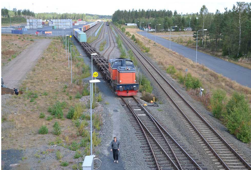
Figur 11 Terminalen i Båramo (Skillingaryd) är en linjeplats som i skrivande stund ansluts till det nya mötesspåret I Skillingaryd (se kapitel 3:2)
