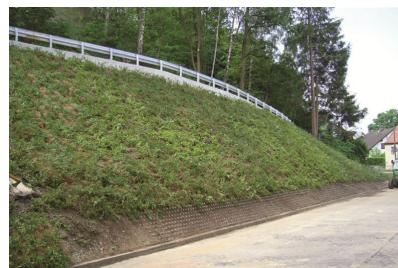
Erosionsskydd/grön slänt. Bildkälla: Veg Tech.
