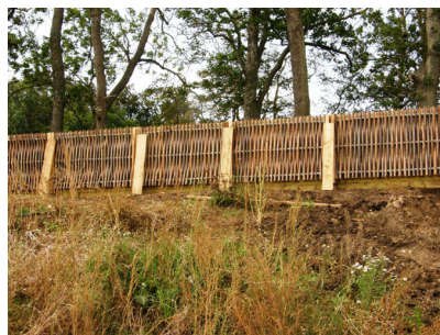
Exempel på bullerskärm av Salix. Skärmen underlättar för klätterväxter att klä in den. Bildkälla: www.byggros.com/sv
