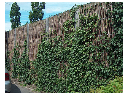
Exempel på bullerskärm av Salix. Skärmen underlättar för klätterväxter att klä in den. Bildkälla: www.byggros.com/sv
