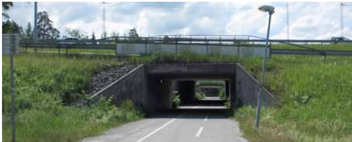
Figur 57 Nuvarande passage under Värmdöleden i Skuru.
