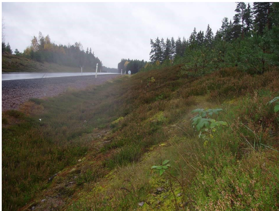
Figur 18. Vägslänt i skogslandskap med naturlig återetablering i avbaningsmassor.
