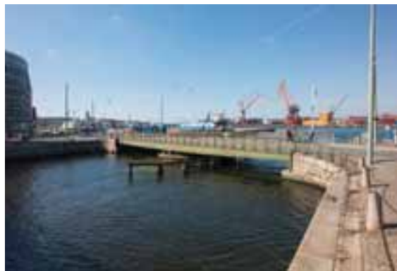
FIGUR 5.2. Stora Hamnkanalen och en del av stråket mot Stora Bommen.
