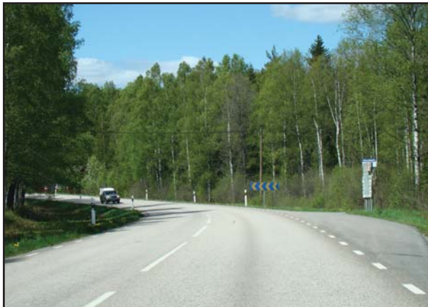
Förbifartens södra anslutning till befintlig väg. (Rakt fram i bild.)
