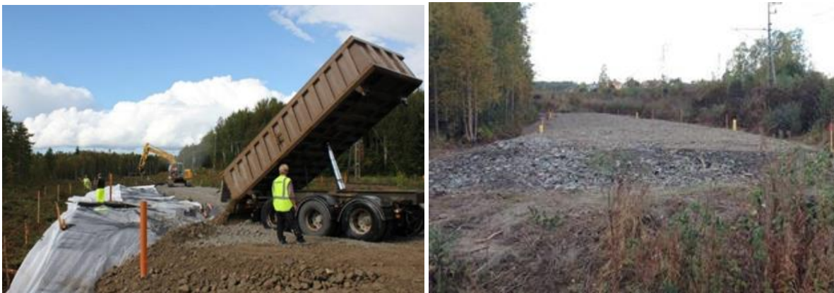
Figur 18. Till vänster: Arbete med tryckbank längs järnväg. Till höger: färdig tryckbank
