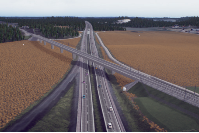
Visualisering av Ostlänken vid trafikplats Vagnhärad. Ostlänken passerar E4 på bro. Utformningen är preliminär och ej detaljutformad.
