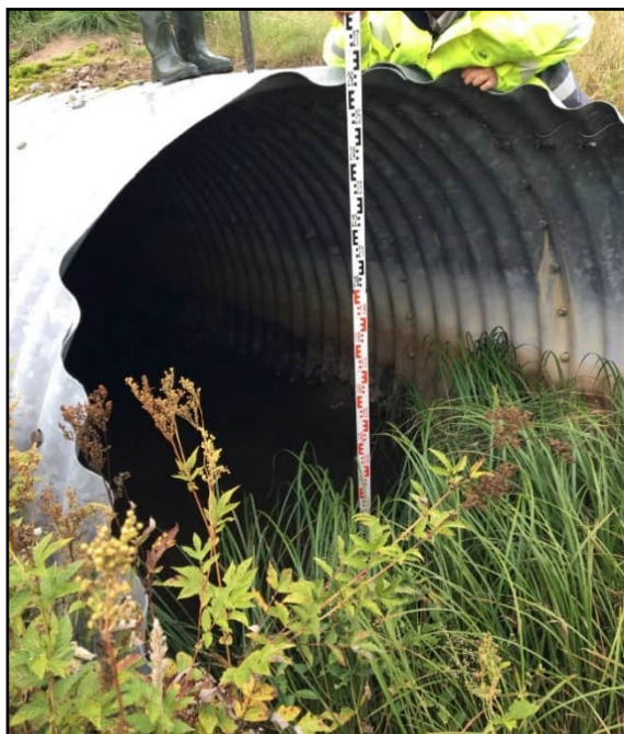
Figur 21 Befintlig bro under E4. Bron är rörformad.
