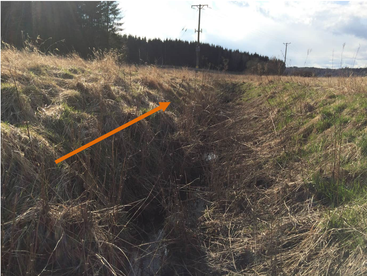
Figur 38 Bild på dike Vagnhärad med strömningsriktning. Strömningsriktningen redovisas med orange pil.
