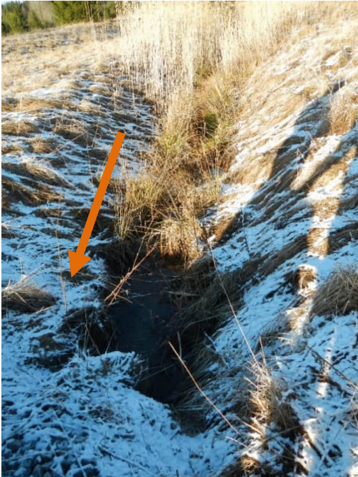
Figur 2 Bild på Dike Nybygget direkt uppströms kulverteringen. Orange pil symboliserar strömningsriktningen.
