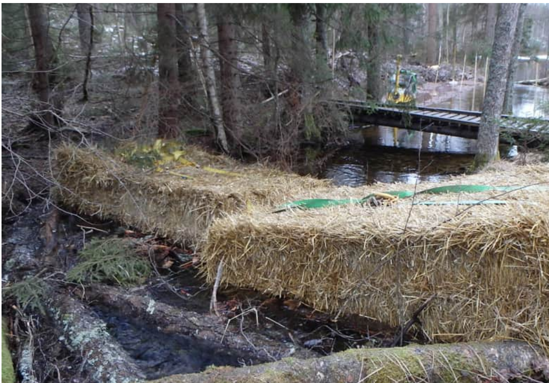
Figur 23: Exempel med skyddsåtgärd där halmbalar lagts ut för att fånga sediment vid arbete i vattendrag. (Källa, foto: Trafikverket, Agne Gunnarsson.)
