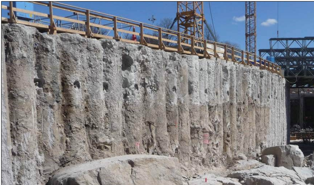
Figur 17: Bakåtförankrad sekantpålevägg (NL12, Norra länken).
