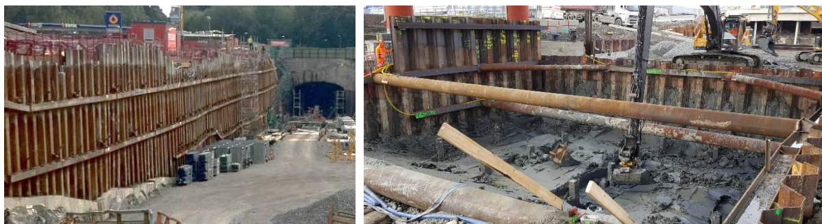
Figur 16: T.v. bakåtförankrad tätspont. T.h. stämpad tätspont.
