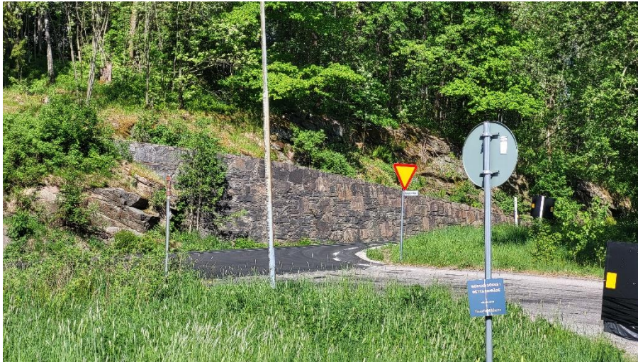
Figur 16. Stenmur vid Ryssbyvägens korsning (källa: Seemly Infra & Miljö AB).
