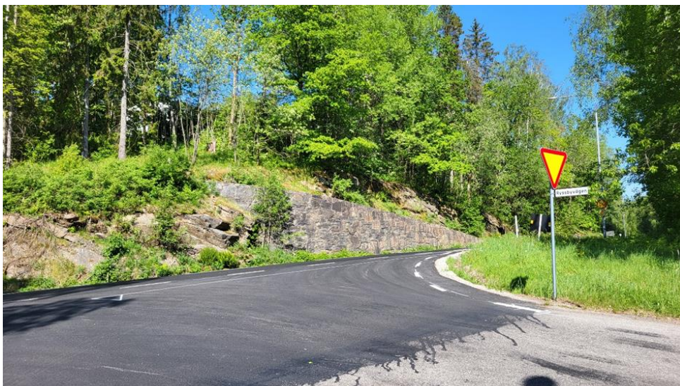
Figur 11. Den befintliga stenmuren mitt emot Ryssbyvägen. (Foto: Seemly Infra & Miljö AB)
