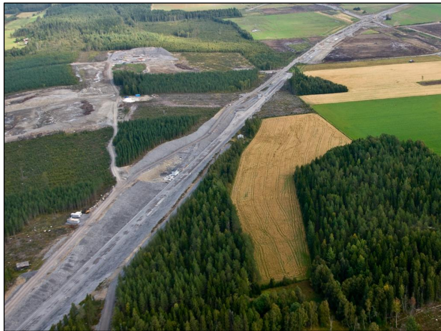
Bild från byggandet av Botniabanan
