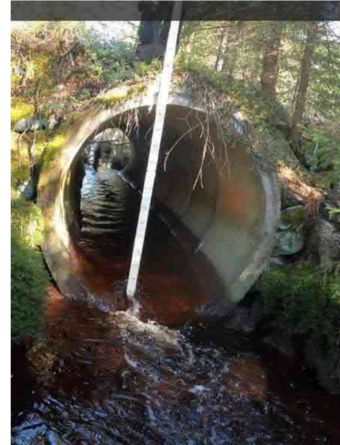
Figur 6.13-4. Trumma med diametern 1400 mm i Slättbäcken. Foto: WSP.
