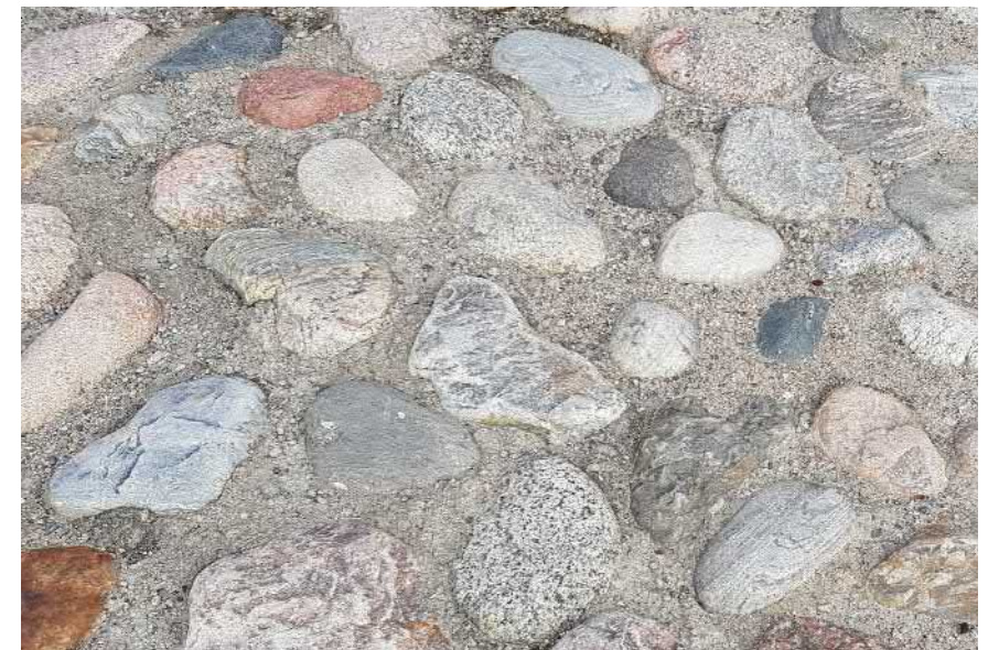
Figur 5.5-1. Exempel på bearbetat ytskikt med fastgjuten natursten. Foto: WSP Sverige AB.
