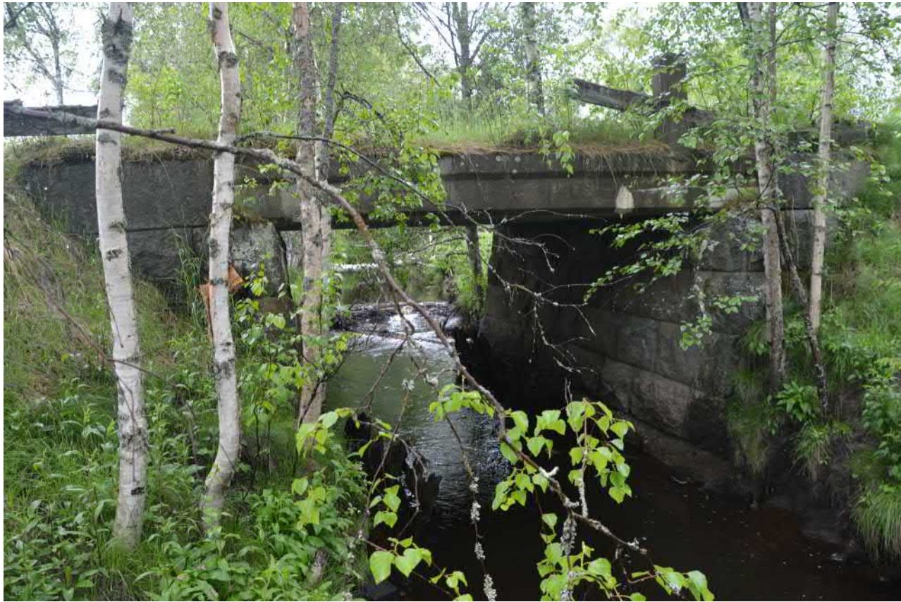
Figur 4.2-33. Stenbron med kallmurade brostöd. Foto: WSP Sverige AB.
