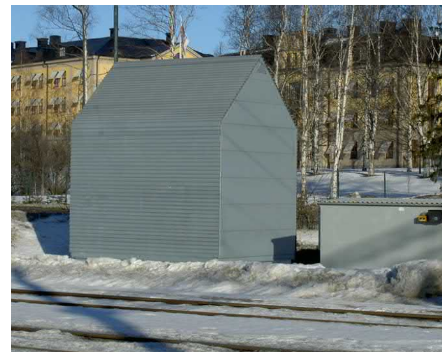
Figur 5.8-2. Foto på mindre teknikhus använt i Botniabanan. Foto: Trafikverket.
