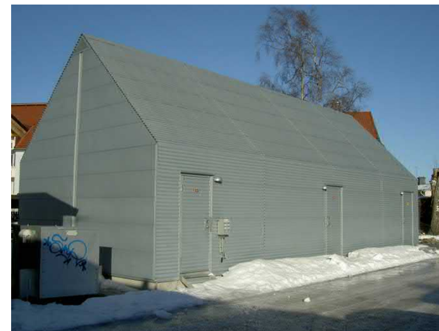
Figur 5.8-1. Foto på större teknikhus använt i Botniabanan. Foto: Trafikverket.
