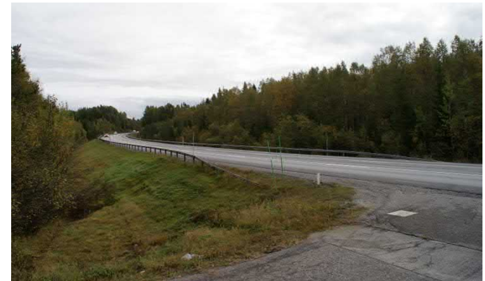
Figur 4.3-4. Järnvägen kommer passera under E4 i det parti som bilden visar. Skogsidan till höger kommer avverkas vid tillfällig omledning under byggnation. Foto: WSP Sverige AB.
