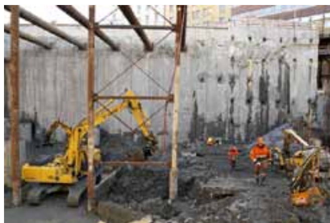
FIGUR 4.19. Exempel på utförande med slitsmur.
