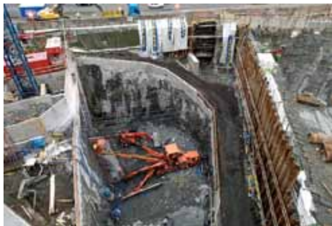
FIGUR 4.17. Exempel på borrhning vid tunnelpåslag.
