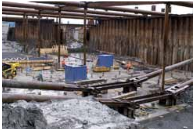
FIGUR 4.18. Exempel på utförande med stålspont.
