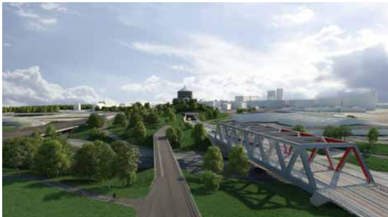
FIGUR 3.2. Vy över dubbelspårsbron och den ombyggda vägbron över E6.
