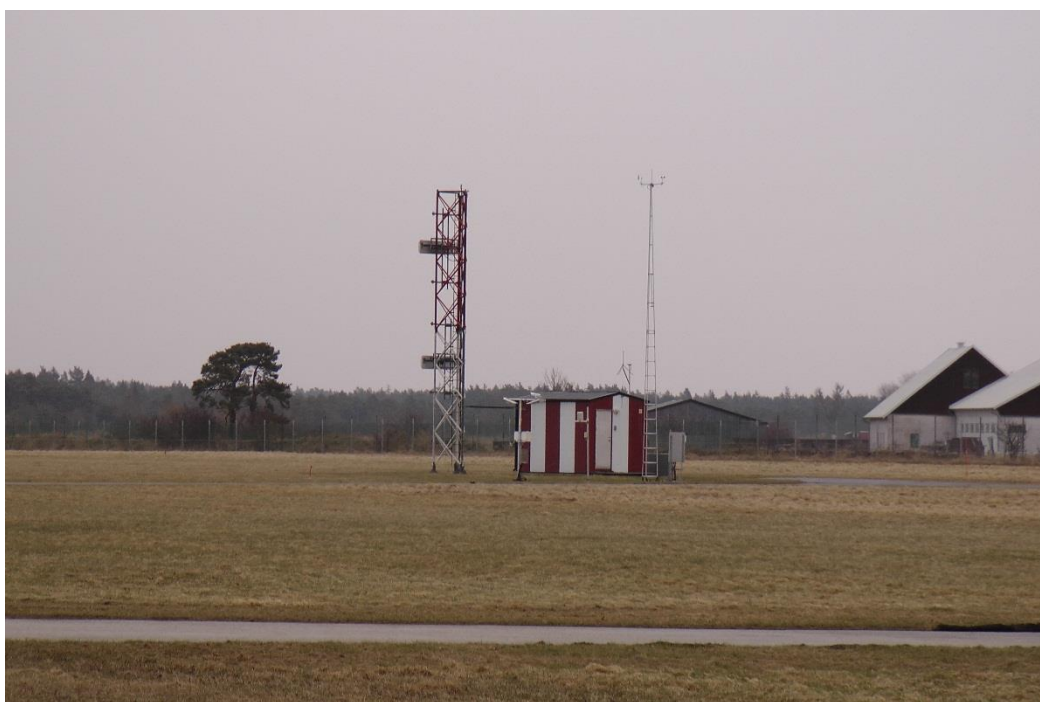
Figur 21 GP: (Glide path) Glidbana, sänder höjd information till flygplanen vid landning i dåligt väder. Används tillsammans med LOC.
