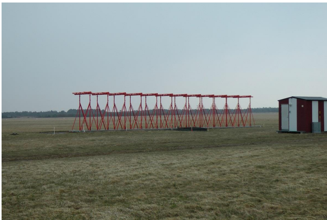
Figur 20 LOC: (Localizer) Kurssändare, sänder riktning information till flygplanen vid landning i dåligt väder. Används tillsammans med GP
