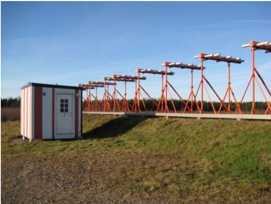
Figur 16. LOC: (Localizer) Kurssändare, sänder riktningsinformation till flygplanen vid landning i dåligt väder. Använd tillsammans med GP.
