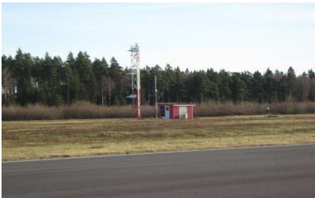
Fig. 27. ILS systemets glidbanesändare och utrustning för avståndsmätning, DME. Foto: Anders Gustafsson
