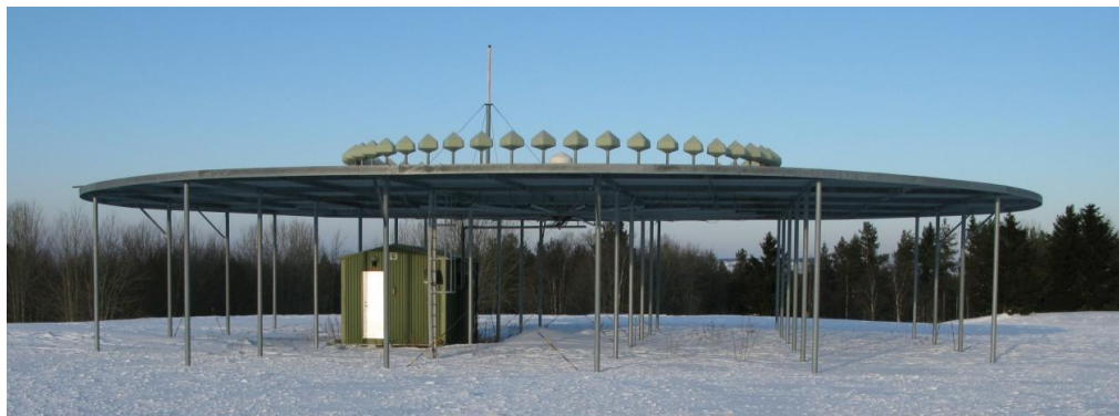
Fig. 25. VOR/DME: Riktad radiofyr med utrustning för avståndsmätning.
