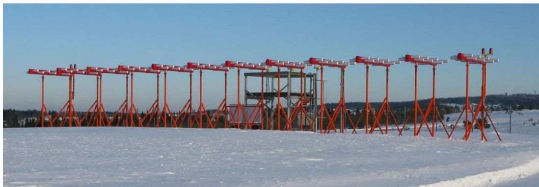
Fig. 15. LOC: (Localizer) Kurssändare, sänder riktningsinformation till flygplanen vid landning i dåligt väder. Används tillsammans med GP.
