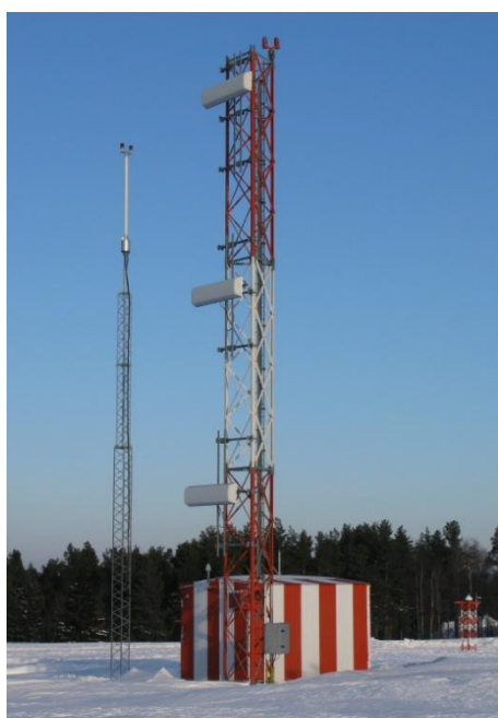
Fig. 16. GP: (Glide path) Glidbana, sänder höjdinformation till flygplanen vid landning i dåligt väder. Används tillsammans med LOC.
