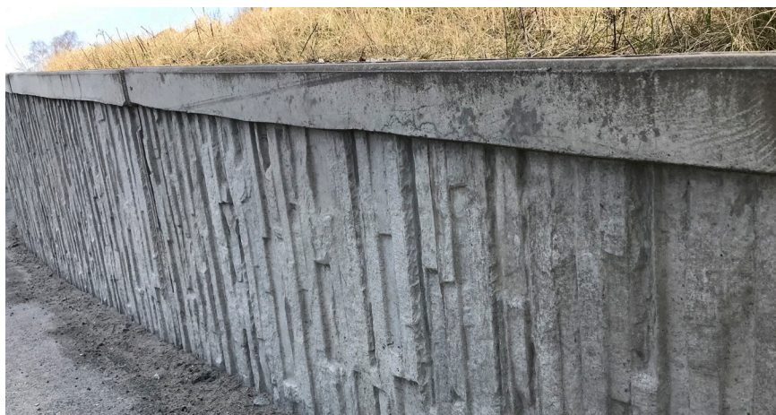
Figur 3.14 Platsfoto: Befintlig stödmur vid Jungfruvägen. L-stöd med reliefmönster och tydligt markerad överkant.
