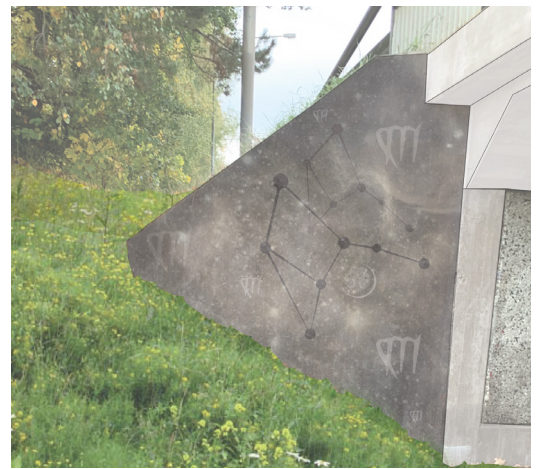
Figur 4.35 Den grafisk betongen på vingmurarna föreslås föreställa stjärntecknet jungfrun, där bakgrundsmotivet är inspirerad av rymdens nebulosor. Motivet görs i fabrik och monteras därefter som en påklädnad på vingmuren.
