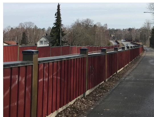
Figur 3.9 Platsfoto: Exempel på låg bullerskyddsskärm utmed väg 260, Gudöbroleden.
