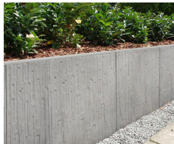
Figur 3.16 Referensbild: L-stöd med reliefmönster. (Bildkälla: Starka)
