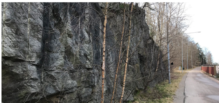
Figur 3.6 Platsfoto: Befintlig bergskärning utmed sträckan.
