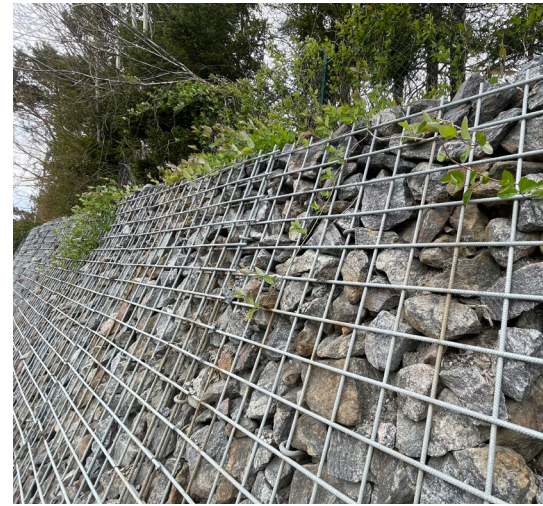
Figur 4.53 Referensbild: Gabionmur med klätterväxter.
