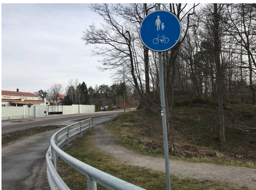
Figur 4.4 Platsfoto: Befintlig gång- och cykelbana precis norr om övergångstället vid Grindstuvägen. Fotot visar en brant slänt ner till öppet vattendrag. I bakgrunden syns även berg i dagen.
