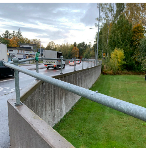
Figur 4.30 Platsfoto: Reliefmönster på befintlig mur/tätt betongstaket vid korsning Skogängsvägen/Gudöbroleden. Stödmuren ersätts med ny och flyttas längre in på privat fastighet.
