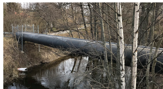
Figur 4.15 Platsfoto: Befintligt ledningsstråk över Gudöån.
