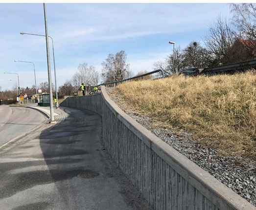
Figur 4.22 Platsfoto: Sofiebergs busshållplats. Befintlig stödmur tar upp höjdskillnaden mot Gudöbroledens parallellväg Önskevägen.
