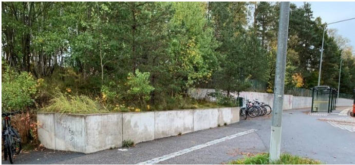
Figur 4:17. Stödmurar vid hållplats Jungfruvägen. Höjden är lägre än 2 meter. Slänten ovanför fortsätter någon meter.
