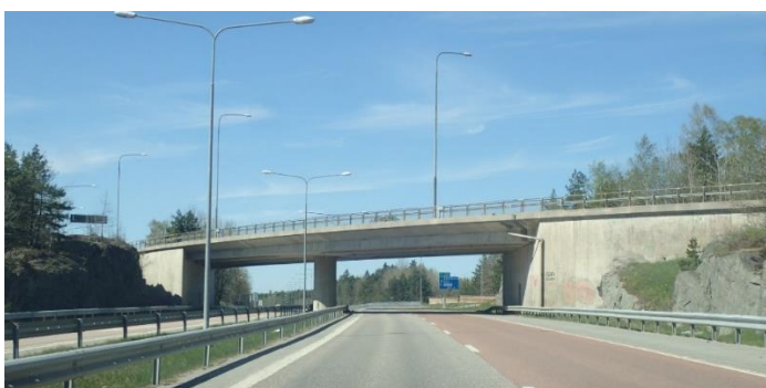
Figur 4:20. Bro 1-118-1 vid tpl Skrubba. En trolig sträckning av ny gång- och cykelväg är förhöjd där vägreolen är idag. Foto från BaTMan.
