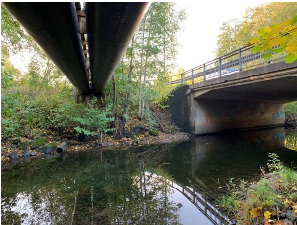
Figur 4:12. Fjärrvärmeledning öster om bro 2-261-1. Från kantbalk till ledning är det cirka 6 meter fritt.
