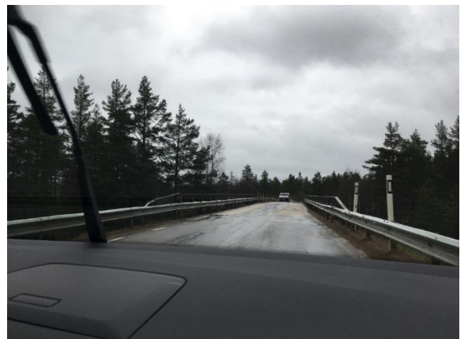
Figur 2.4 Bron över järnvägen sydost om Sveg.
