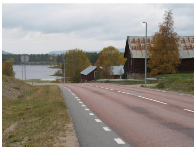
Figur 10.18 Bebyggelselämning (byggnaden närmst till höger om vägen) nära befintlig väg genom Byvallen.
