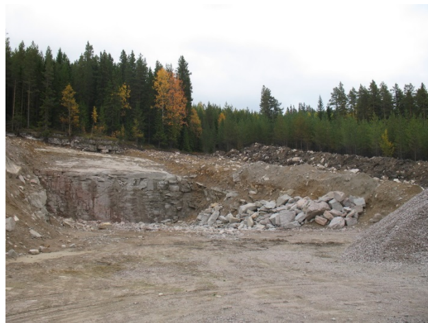
Figur 10.35. Husbehovstäkt på sydvästra sidan av Nonsberget (september 2017).
