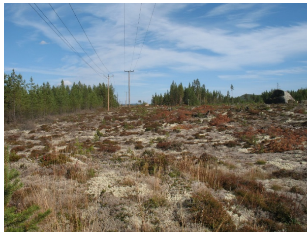
Figur 10.38 Ledningsgata med elledningar cirka 1,5 kilometer söder om Älvros.
