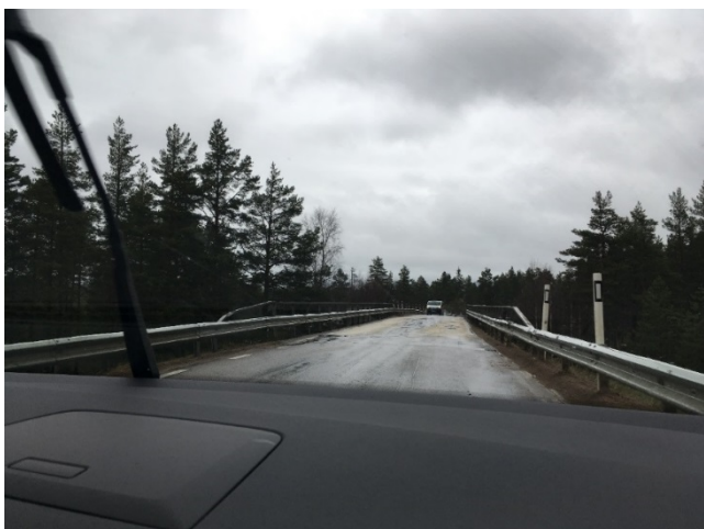
Figur 2.5 Bron över järnvägen sydost om Sveg.
