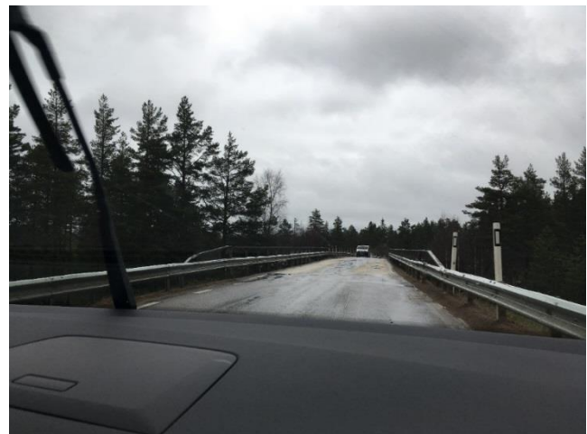
Figur 2.4 Bron över järnvägen sydost om Sveg.
