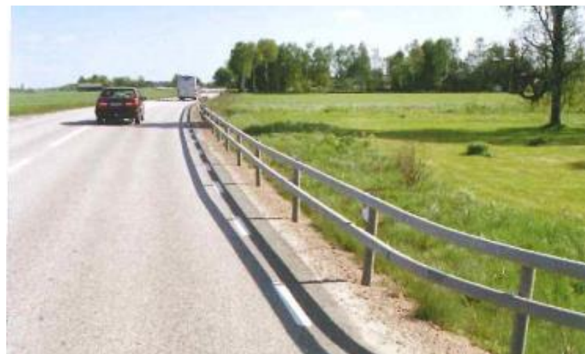
Figur 64. Rörräcke kan användas i Älvros samhälle.
