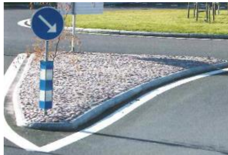
Figur 61. Ett annat markmaterial i refugerna skapar en tydlig kontrast till körbanan.
