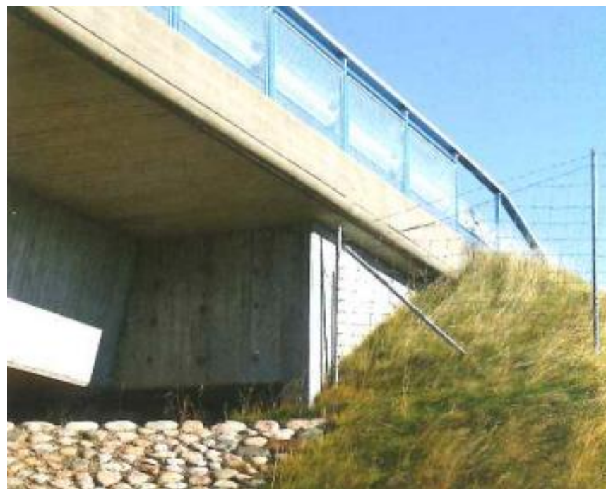
Figur 76. Viltstängsel ska monteras så överkant en av stängslet inte når över kantbalken på bron för att inte störa utsikten (vägverket, 2006)
