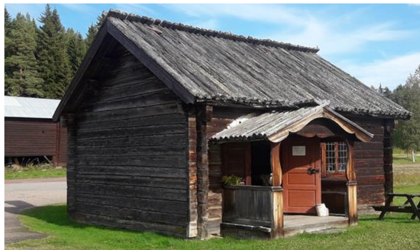
Figur 82. Träbebyggelse med grånad fasad och tak, Älvros.
