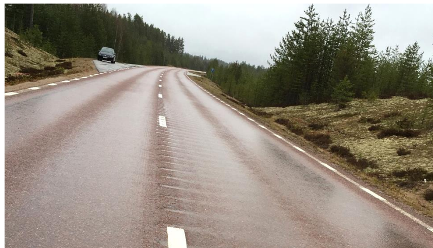
Figur 32. Tvåfältsväg med räfflad mittlinje (E45)
