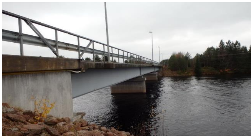
Figur 83. Befintlig bro över Ljusnan med armaturer.
