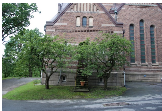
Figur 60. Hagtorn vid den östra fasaden.
