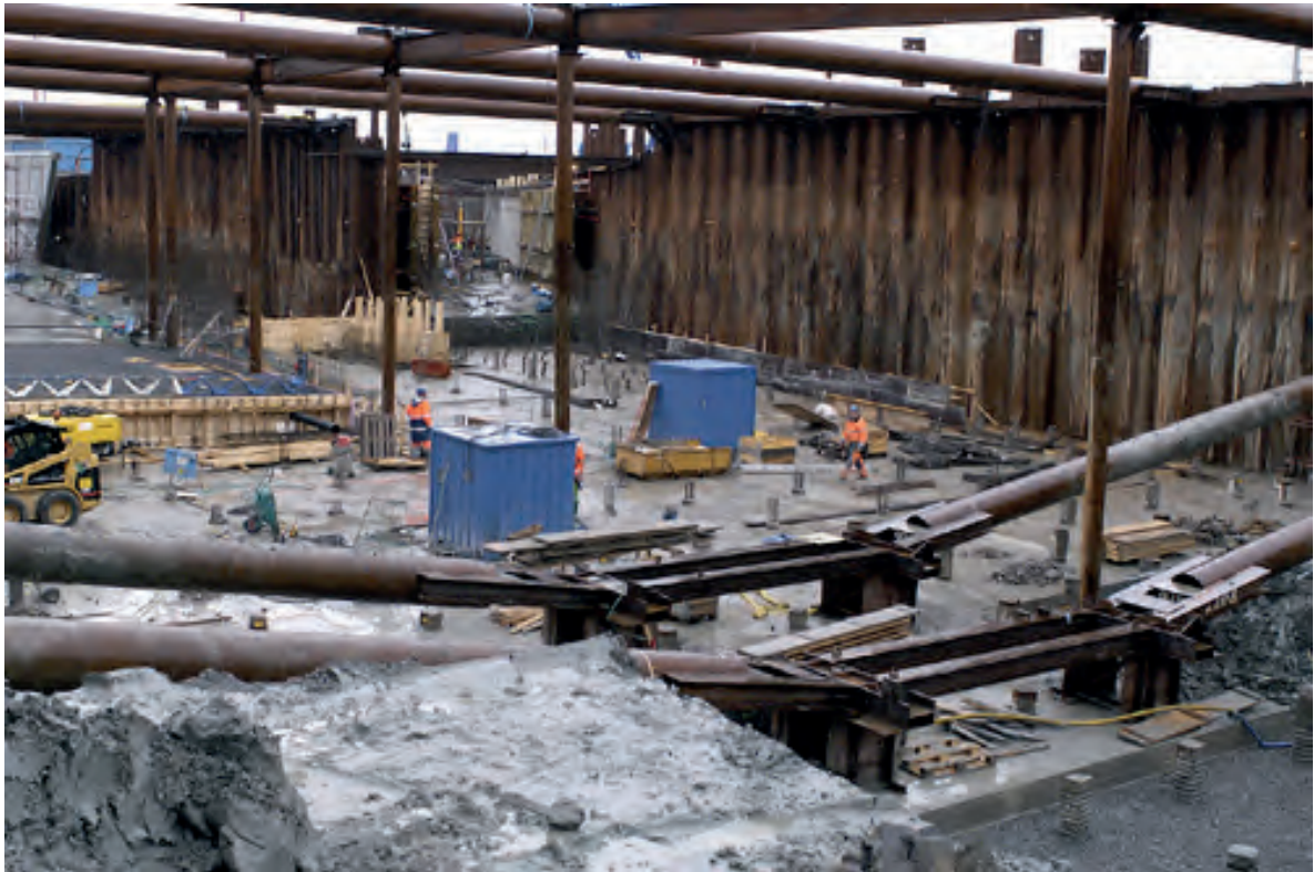
FIGUR 5.5 Stålspont (med stämp) vid arbeten i Götatunneln.
