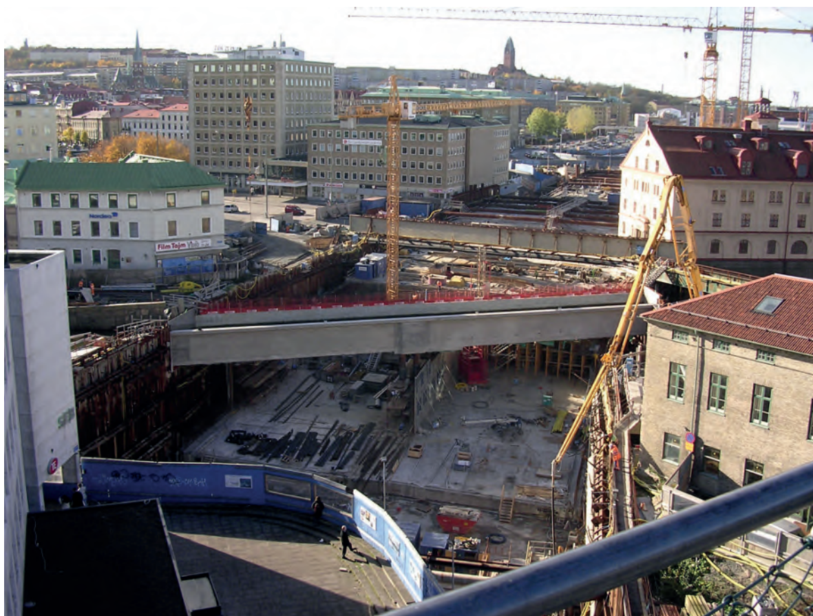
FIGUR 5.4 Jordschakt vid bygget av Götatunneln.
